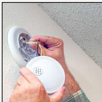
Remplacement piles détecteur
